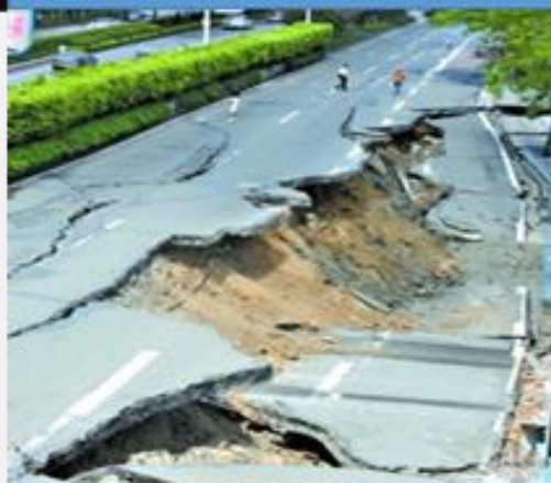
正面土体失压： 路面坍塌造成环境破坏
