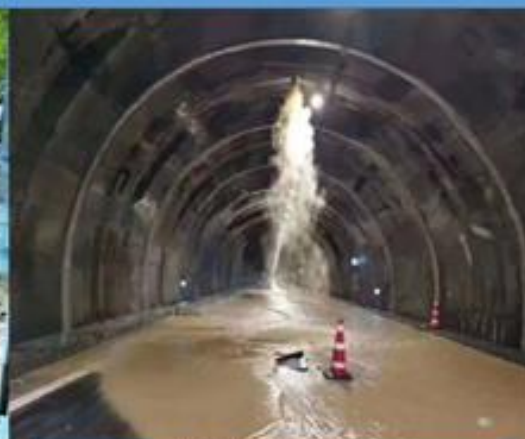
掘进状态失稳： 盾尾密封损坏导致隧道产生漏水风险
