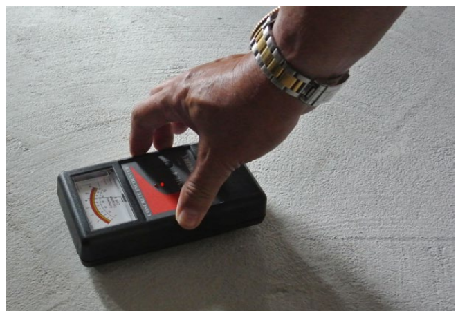
Checking moisture content
